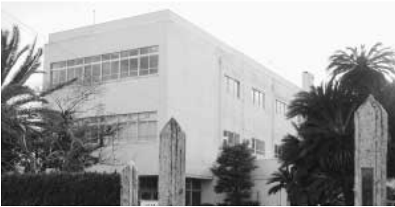
南部小学校1号館（昭和31年建築）
