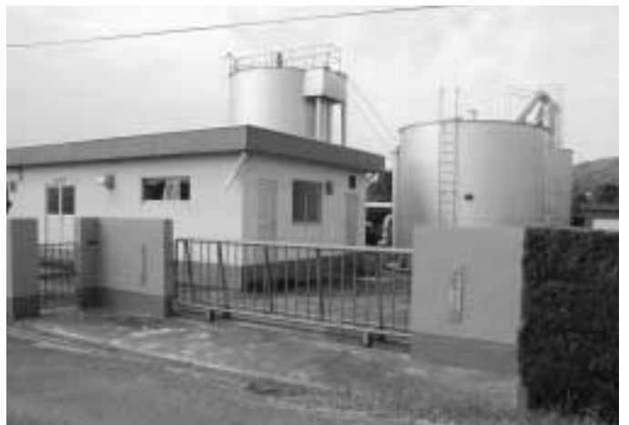
南部町上水道 浄水場（南部町気佐藤）
