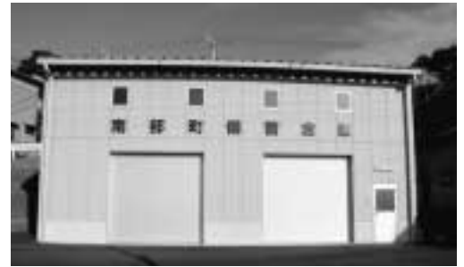
備蓄倉庫（南部町埴田）
