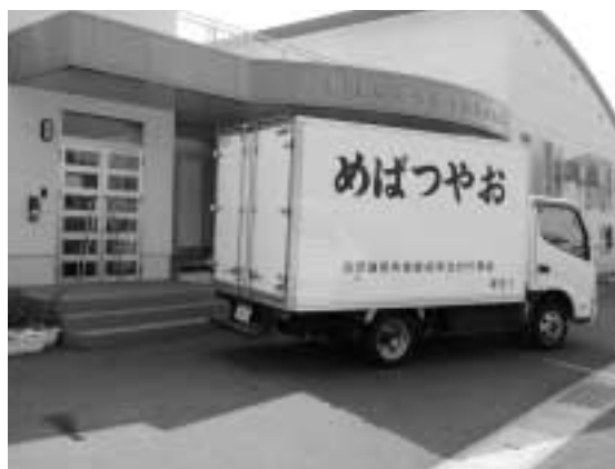
給食センター外観
