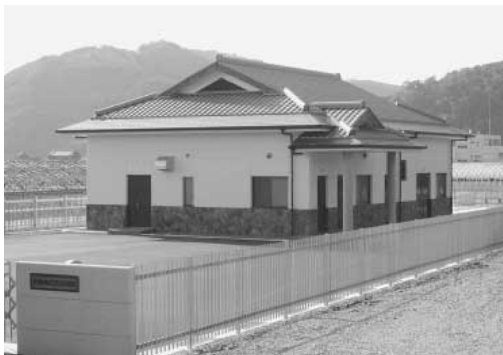
南部川村本郷地区農業集落排水処理場（南部川村東本庄）
